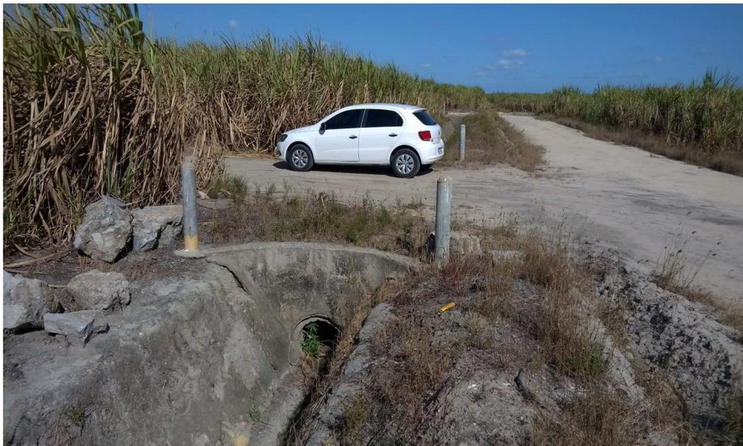
**Imagem 12** - Bueiro existente em determinado ponto do traçado.
