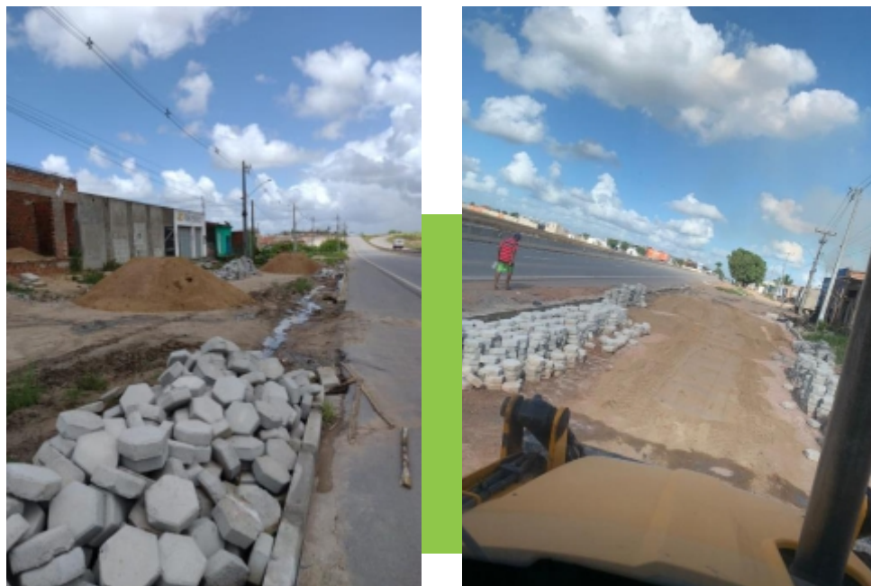
CALÇAMENTO DAS RUAS ÀS MARGENS DA AL-220
